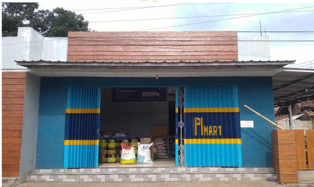
Kondisi tampak depan Kios Barokah
