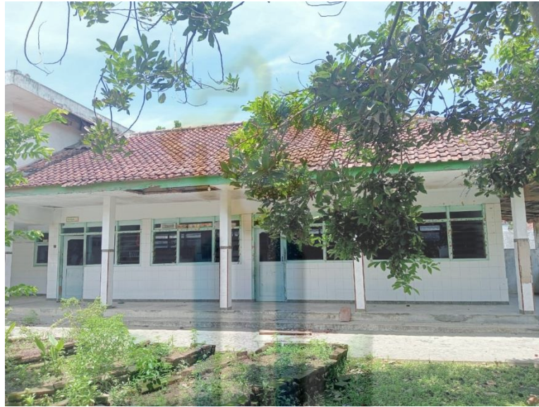
Asrama Putri yang sudah tidak di tempati
