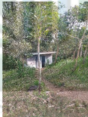
Gambar 2 : Kamar Mandi (Sumber : Dokumentasi Pribadi)
