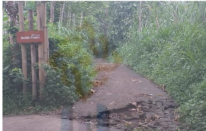
Gambar 4.12 Kondisi Akses menuju Bukit Dami (Sumber : Dokumentasi Pribadi)
