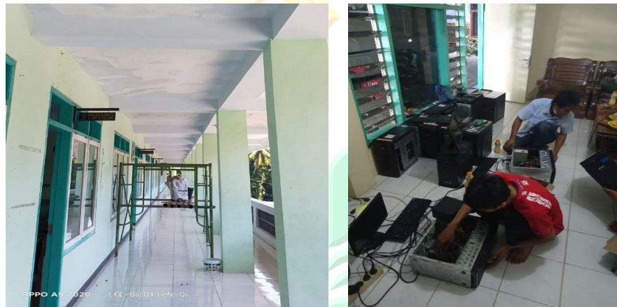
Gambar 4.7 Pemeliharaan Gedung dan Komputer
