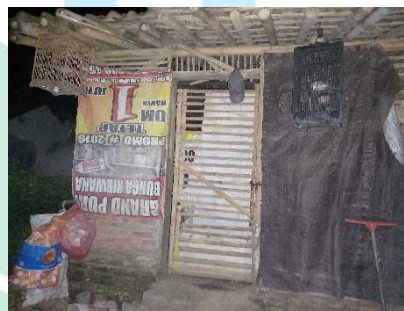
Gambar 4.4 Kondisi Rumah Bapak Zuhri Berdekatan Dengan Kandang Ternak
