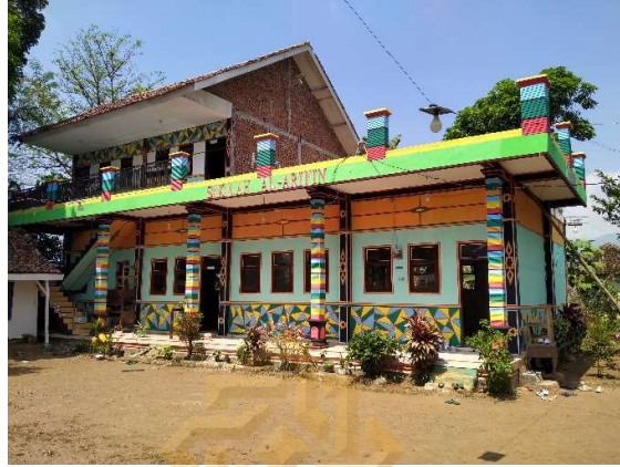
Gambar 13 Gedung Madrasah Aliyah Al-Arifin
