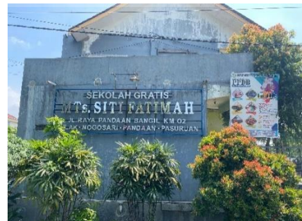
Gedung sekolah MTS 26 April 2024
