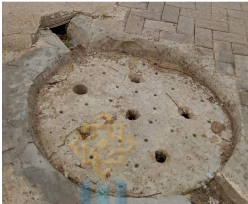
gambar 4.6 Gambar sumur serapan
