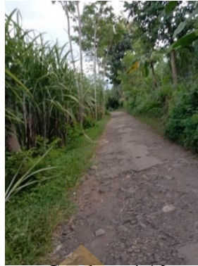
Gambar: 4.10 Infrastruktur Jalan menuju Wisata Bukit Dami (Sumber: Dokumentasi pribadi)
