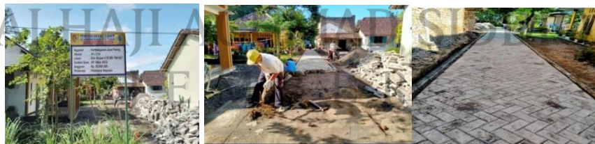
Gambar 4.10 Pembangunan Jalan Paving Desa Karangduren
