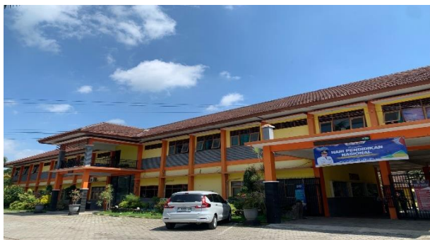
Gambar 4.23 Gedung SMAN 3 Jember
