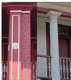
Gambar 3.3 Pilar Rumah pada Rumah Kampung Kemas (Dokumentasi Pribadi)
