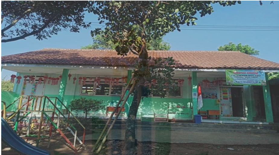
Gambar 1 SPS Manggis 20 tampak depan
