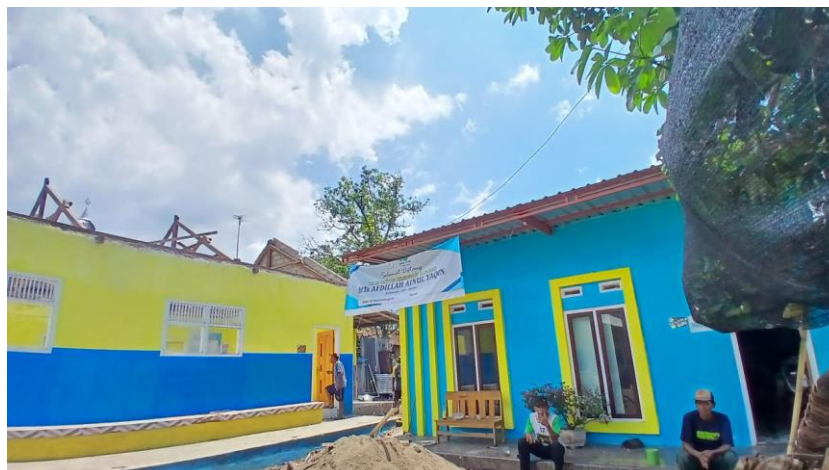
Gambar 4.1 Renovasi Gedung KBM 62
