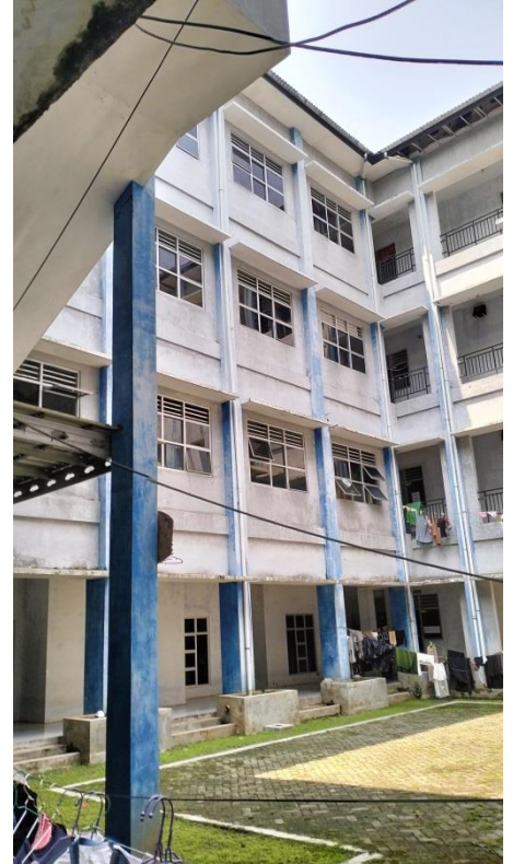
Dokumentasi asrama mahasantri Blok Utara (BSU)
