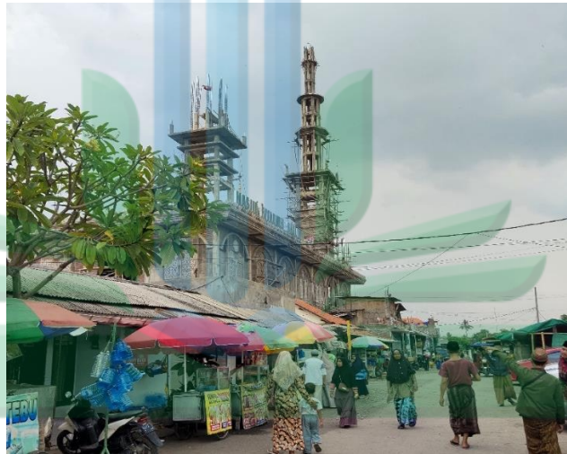
Gambar 4.1 Masjid Riyadlus Sholihin Makam Habib Sholeh Tanggul Makam Habib Sholeh bila dilihat secara geografis terletak di wilayah Desa Tanggul Kulon Kecamatan Tanggul Kabupaten Jember dan berbatasan dengan rumah warga yaitu sebelah selatan, sebelah utara berbatasan dengan rel KAI, sebelah timur berbatasan dengan balai desa dan sebelah barat berbatasan dengan rumah warga.
