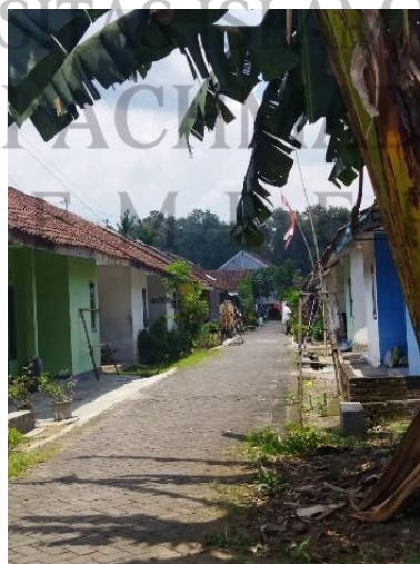
Gambar Perumahan Banjir di Desa Kaliputih. (Sumber Foto: Dokumentasi Pribadi)
