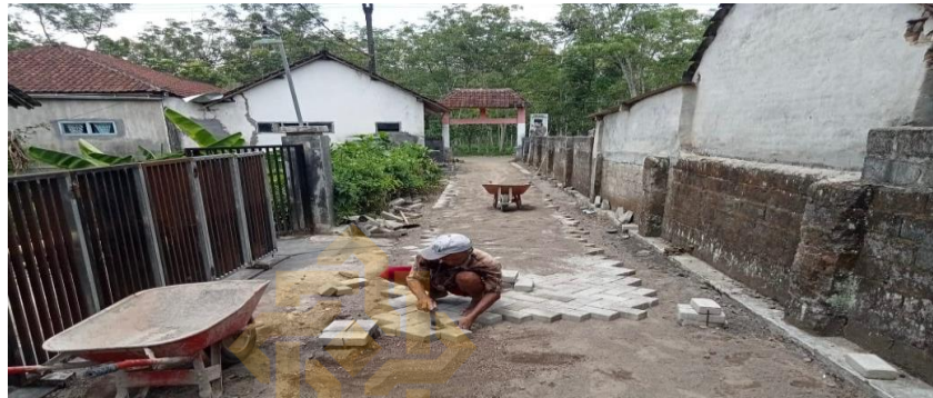
Gambar 4.2 Pelaksanaan Pembangunan Paving
