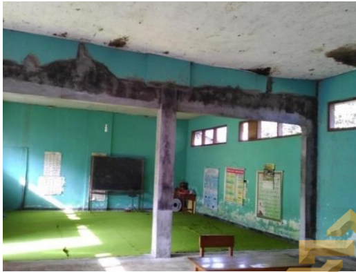
Dokumentasi renovasi gedung SDN Jurangsapi 1
