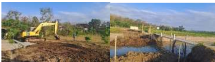
Gambar 4.8 Dokumentasi Pelebaran Jalan dan Jembatan (Sumber: Dokumentasi Pribadi)
