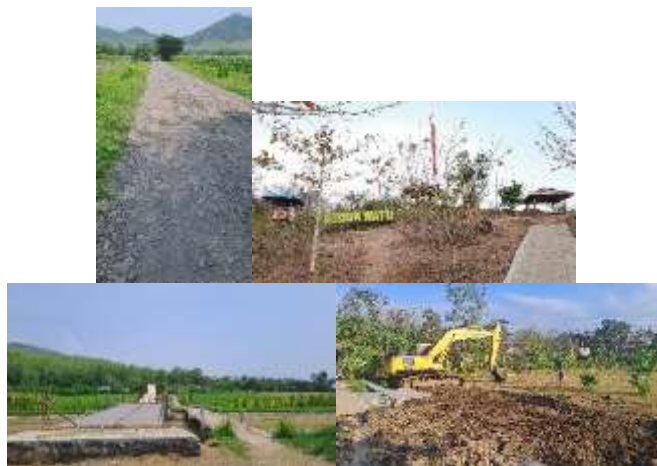
Gambar 4.12 Dokumentasi Infrastruktur Gumuk Watu (Sumber: Dokumentasi Pribadi)
