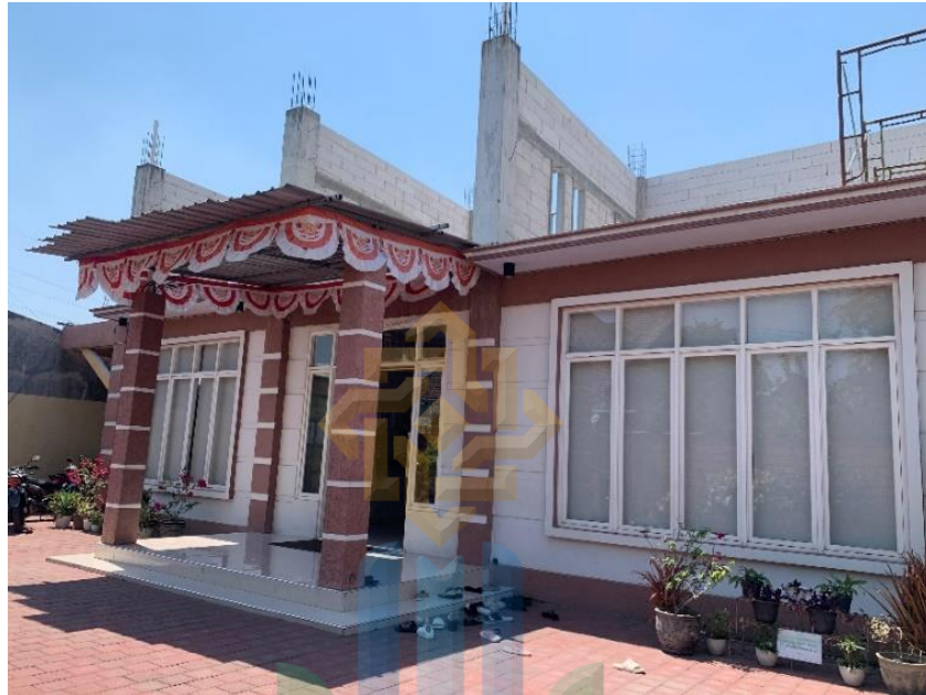
Gambar. Gedung MA Al-Machfudzoh
