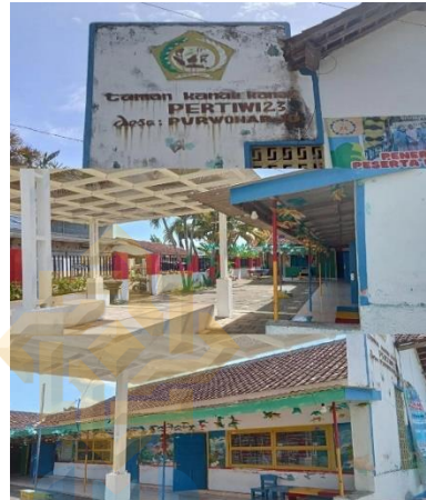
Gambar 4.1 Nampak depan gedung sekolah TK Pertiwi 23 Purwoharjo Banyuwangi 67
