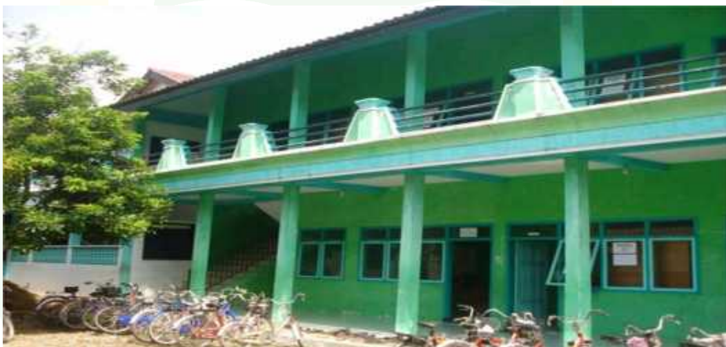
Ruang Kelas MTs Ma'arif NU Jenggawah JemberS
