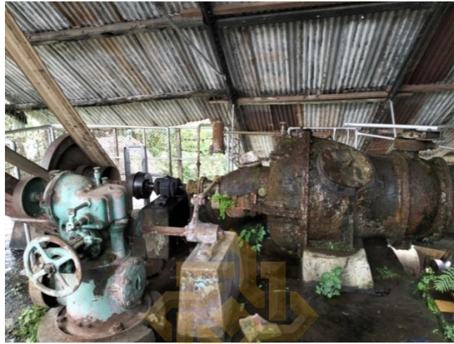
Gambar 2. 4 Mesin turbin pembangkit listrik tenaga air
