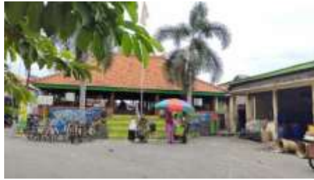
Gambar lampiran Tampak depan Bale Kambang atau Bale Gede Sumber: dokumen pribadi
