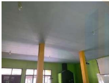
Kondisi bola lampu
