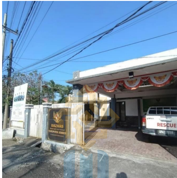
Tampak Depan Kantor BAZNAS Kabupaten Jember
