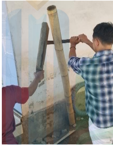
Gambar 4. 7 Pembelahan Bambu
