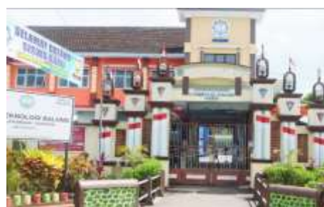
Gedung Sekolah Menengah Kejuruan Teknologi Balung Jember
