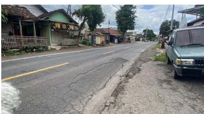
7. Jalan Desa Pakusari
