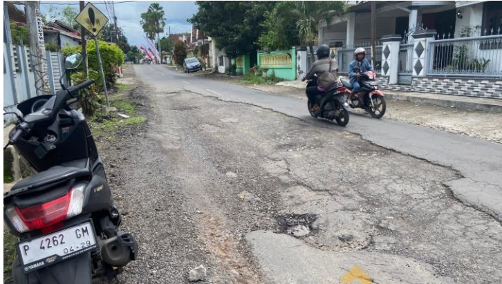
8. Jalan Desa Kalisat
