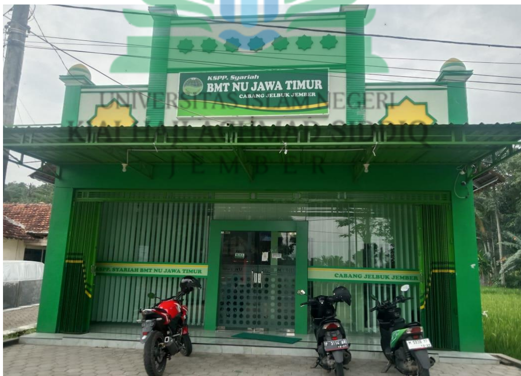
Gambar 5.7 Tampak depan kantor BMT NU Kantor Cabang Jelbuk
