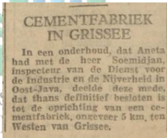
Gambar 12 Koran terbitan Kolonial Belanda tentang rencana pembangunan Pabrik Semen Gresik
