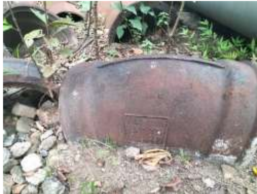
Gambar 3.5 Bagian sambungan pipa tahun 1978 yang sudah tidak berfungsi (Sumber: Dokumen peneliti), 23 Mei 2025.
