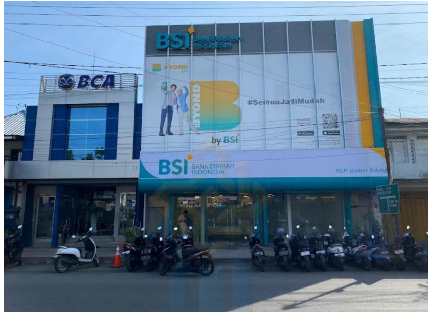
Dokumentasi Lokasi BSI KCP Jember Balung
