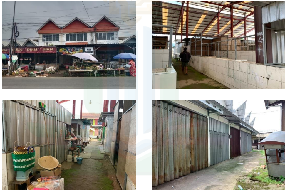
Gambar 4.2 Kondisi Pasar Manggisian Pasca Revitalisasi
