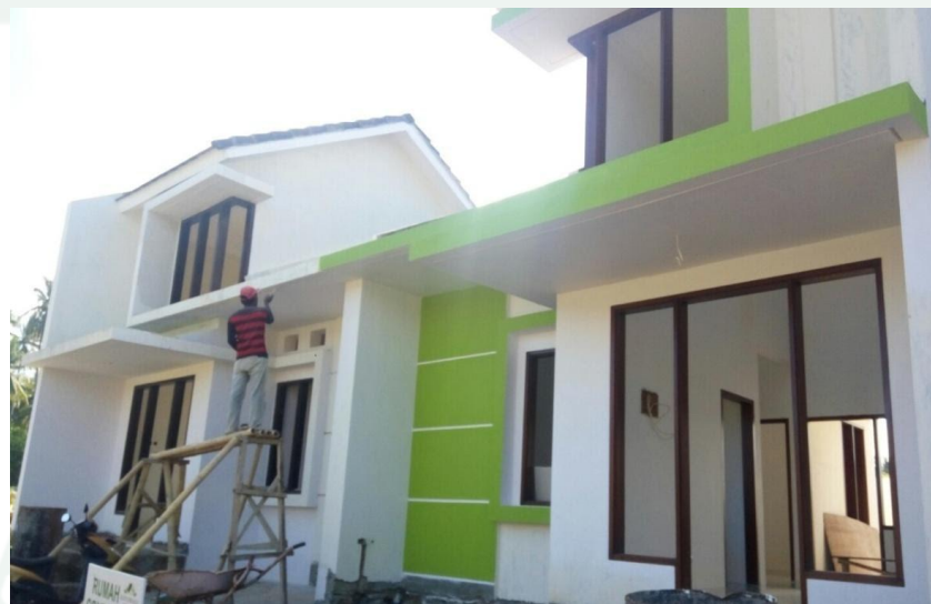
Foto Dokumentasi Pembangunan Unit Rumah di Cordova Residence
