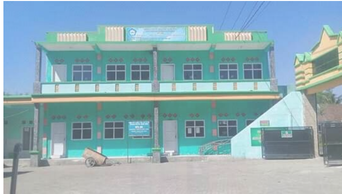
Gambar 1. Gedung MTs Darul Huda
