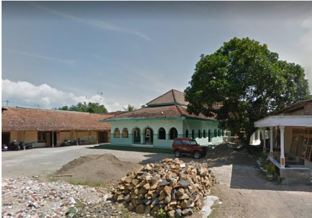
Sebelum renovasi atau kondisi asli masjid
