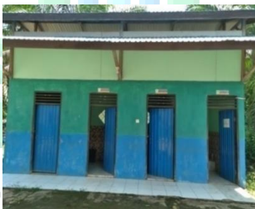
Gambar 4.11 Toilet siswa dan toilet guru MTs Negeri 5 Tabalong
