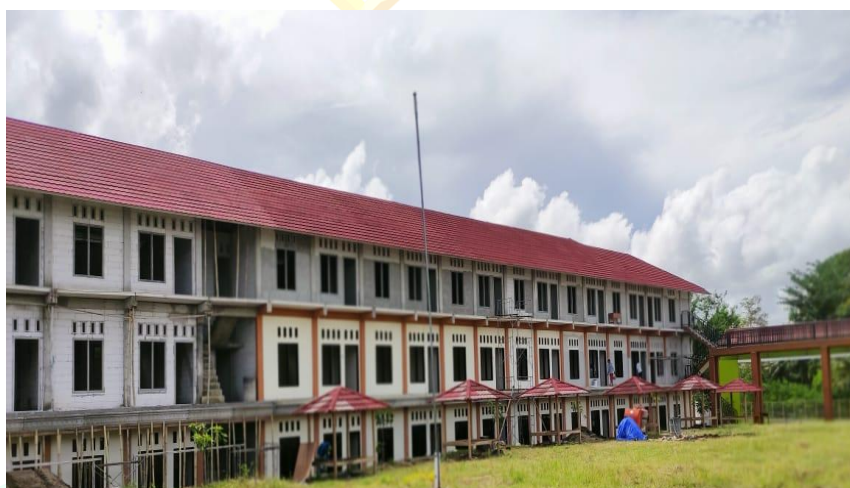
Gambar 4.7 Gedung lama dan Gedung baru masih proses tahap penyelesaian
