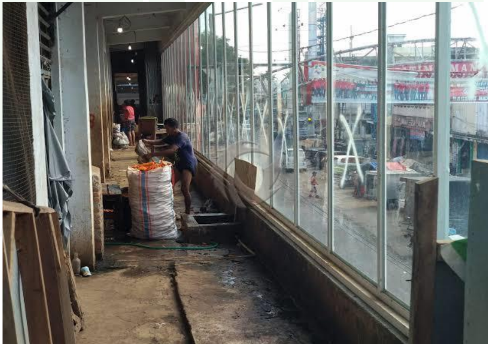
Dok 12 : Kondisi bagian pinggiran Pasar yang telah di revitalisasi (31-01-2020)
