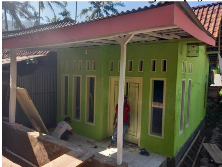
Kondisi Rumah ibu misna setelah di renovasi dalam program RS-RTLH
