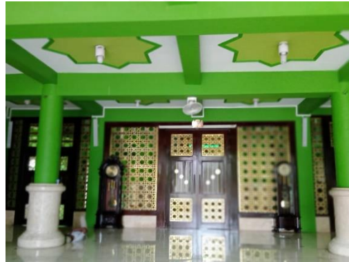
Gambar Pintu Utama Masjid Jami' Al-Abror
