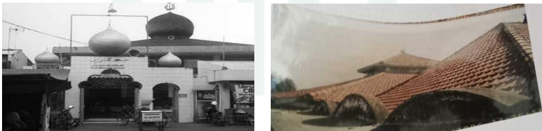
Gambar 14 Atap Masjid Jami' Al-Abror Renovasi yang ke 3 dan yang ke 4
