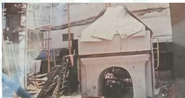
Gambar 17 Gapura Masjid Jami' Al-Abror renovasi
